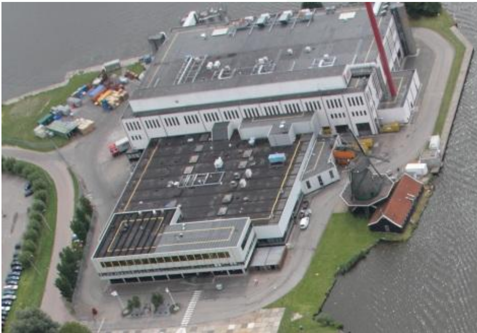
Luchtfoto van het fabriekscomplex van Duyvis met rechts oliemolen de Ooijevaar.
