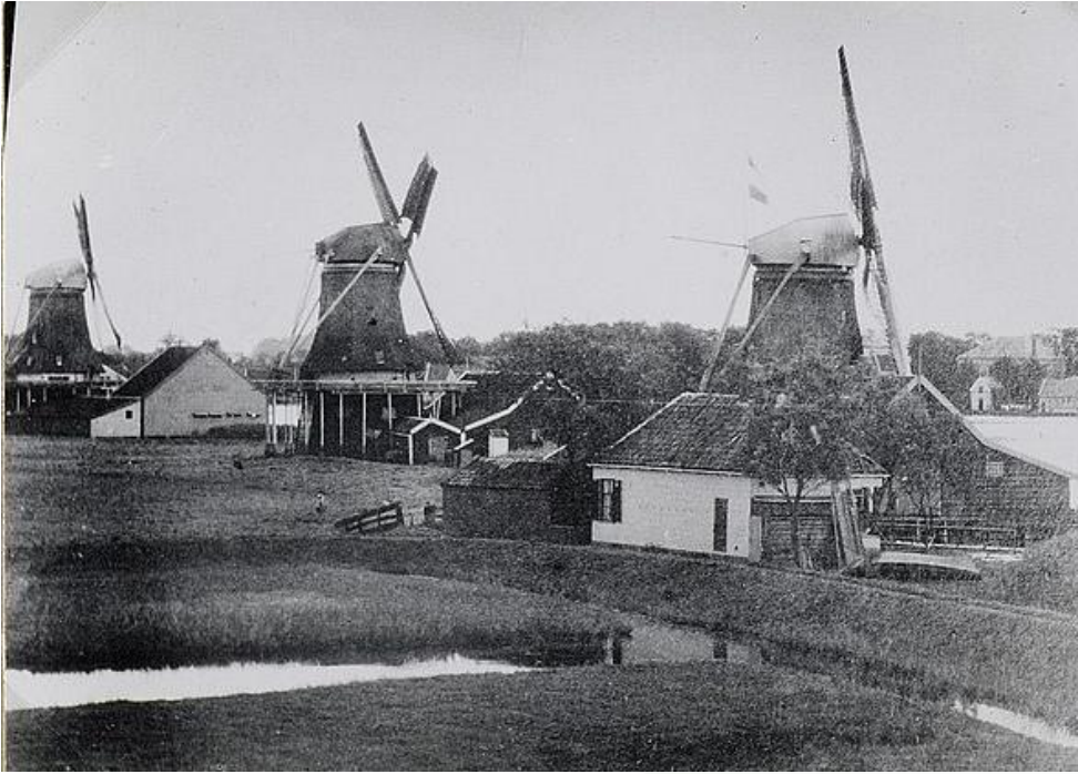
Situatie van oliemolen De Ooijevaar met links oliemolen De Wachter en rechts oliemolen De Windhond. De beide laatste molens hadden een met hout bedekte kap. Foto van voor 1891.
