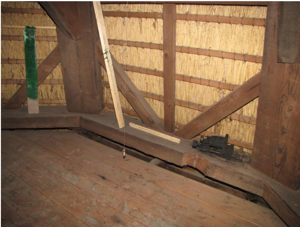
Tussentafelement molen met daarboven het vernieuwde achtkant.
