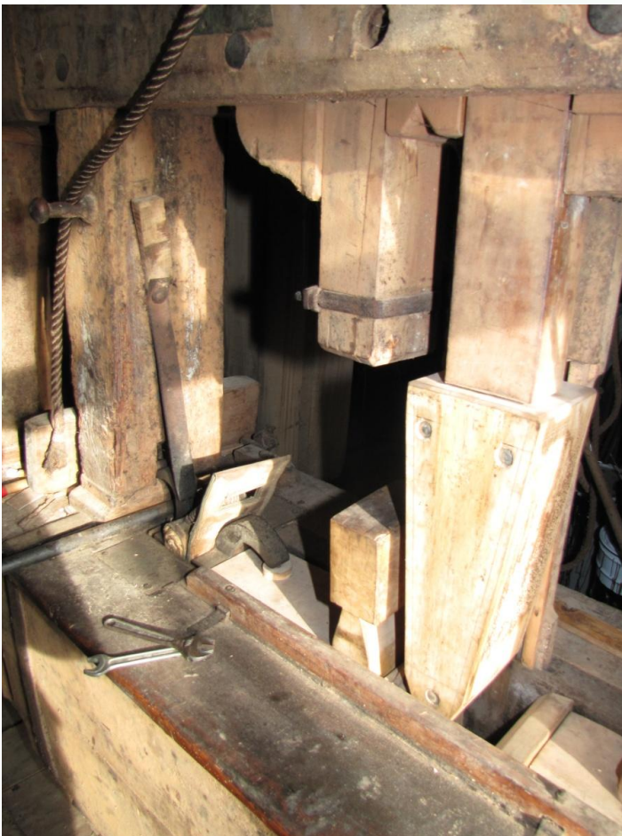
De heien met de slaghei en loshei
